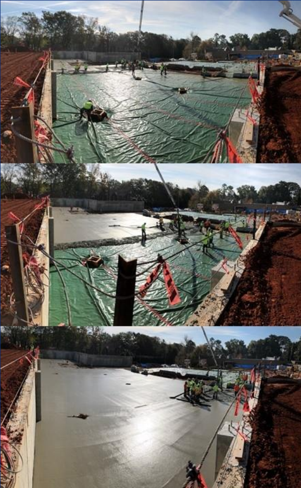
Lower level slab on grade pour in progress
